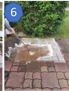
6 Mit Hochdruck- reiniger (Flachstrahldüse) gründlich die Platten reinigen
