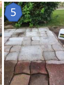
5 In der Einwirkzeit ca. 15 Minuten mit Schrubber einarbeiten
